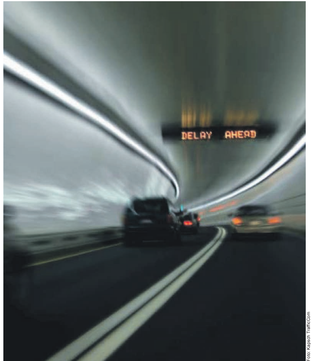
Der Boston Central Artery mit dem Tunnelsystem IPCS von Kapsch TrafficCom
